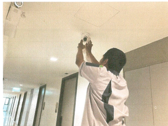
รูปภาพที่ 2.54 การตรวจสอบระบบกล้องวงจรปิด
