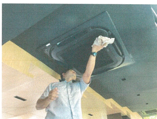
รูปภาพที่ 2.35 การทำความสะอาดและตรวจเช็คเครื่องปรับอากาศ
